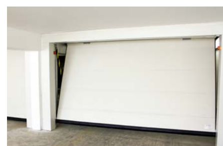
tablier avec panneaux isolants 40mm
