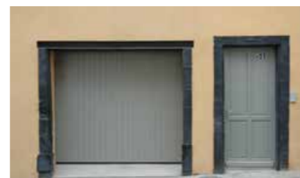
Tablier à lattes en aluminium, doubles parois isolées
