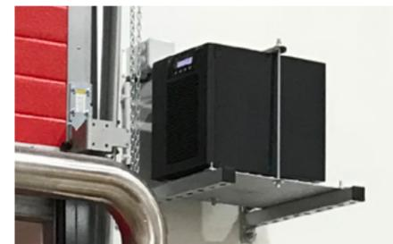
Onduleur pour manoeuvre de secours en cas de coupure de courant
