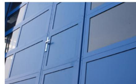
Remplissage en tôles aluminium pleines ou perforées
